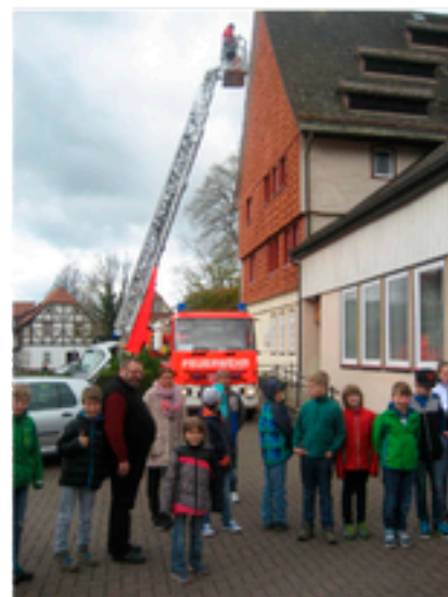
Die Nistkästen werden am Pfarrhaus angebracht
