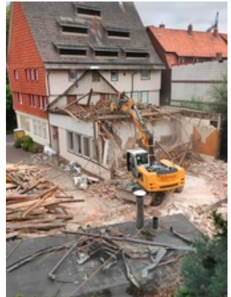
Die Abbrucharbeiten am Pfarrheim haben begonnen
