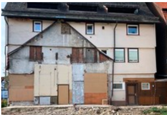
Die östliche Pfarrhausfassade vor der Sanierung
