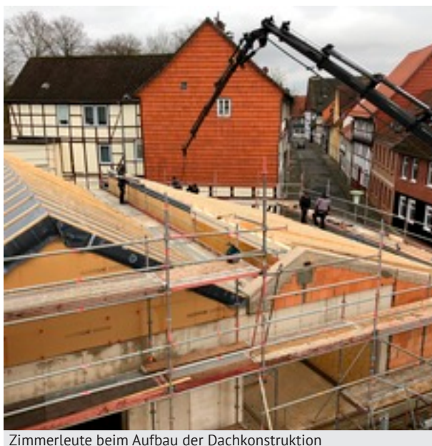
Zimmerleute beim Aufbau der Dachkonstruktion
