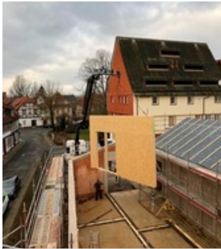
Komplette Wandelemente werden eingesetzt
