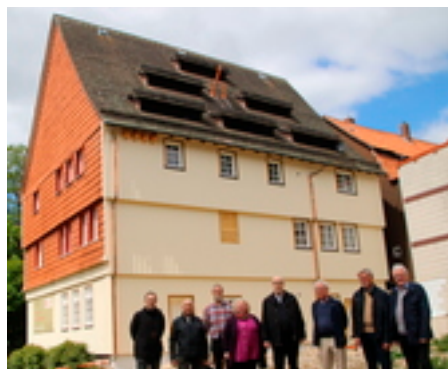
Mitglieder von Kirchenvorstand und Neubaus-Ausschuss vor der sanierten Pfarrhausfassade
