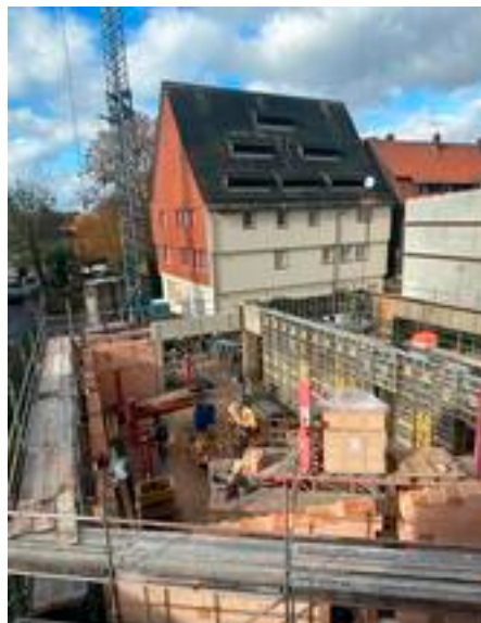
Stand der Bauarbeiten am 8. November
